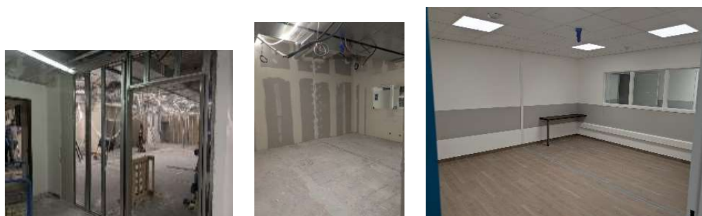
Figure 21 - Chronophotographie du chantier
